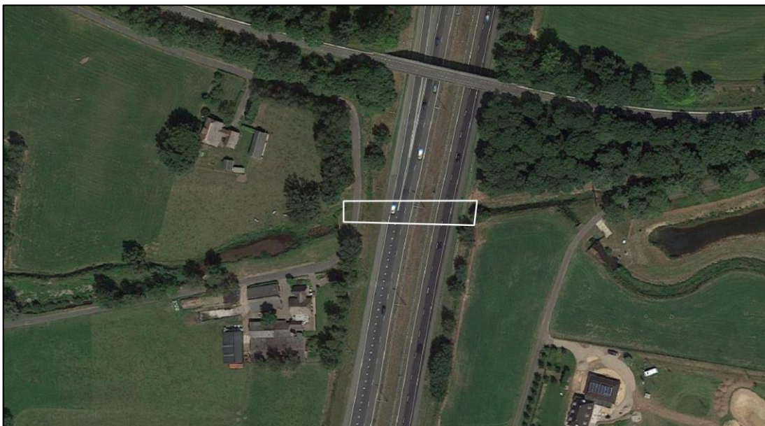
Figuur 6. Ligging van de eenzijdige loopplank 220,100.
