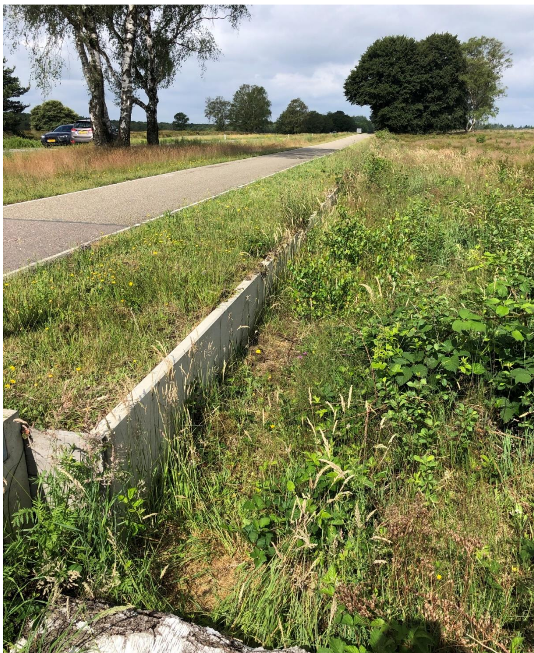
Afbeelding 14: Begroeiing en overgroeiing langs een van de geleidingsschermen bij Herpetoduct Midden, juni 2021 (R. Struijk).
