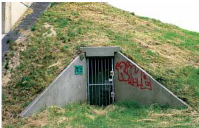
Een vleermuiskelder langs de A27 bij de Stichtse Brug.
