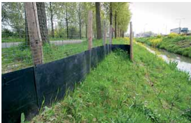
Amfibieënscherm langs parallelweg A13 bij Delft.
