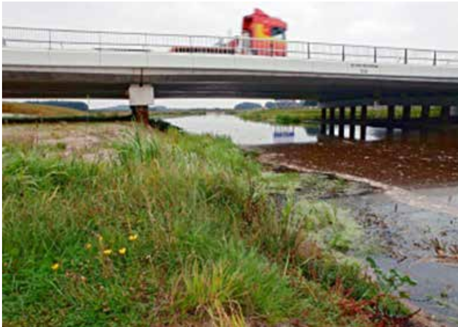
Figuur 4.2: Gerealiseerde doorlopende oever onder de N33 (Foto: Hans Dekker)
