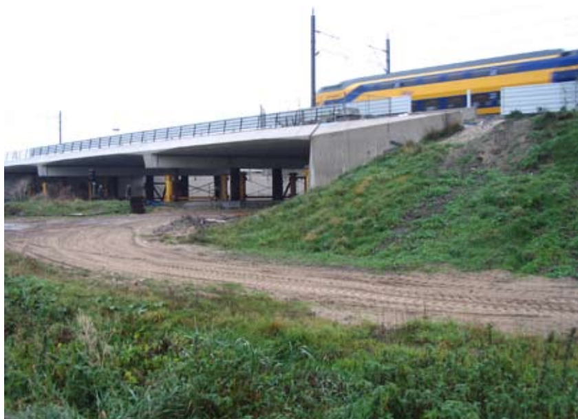
Ecopassage Nieuwe Wetering
