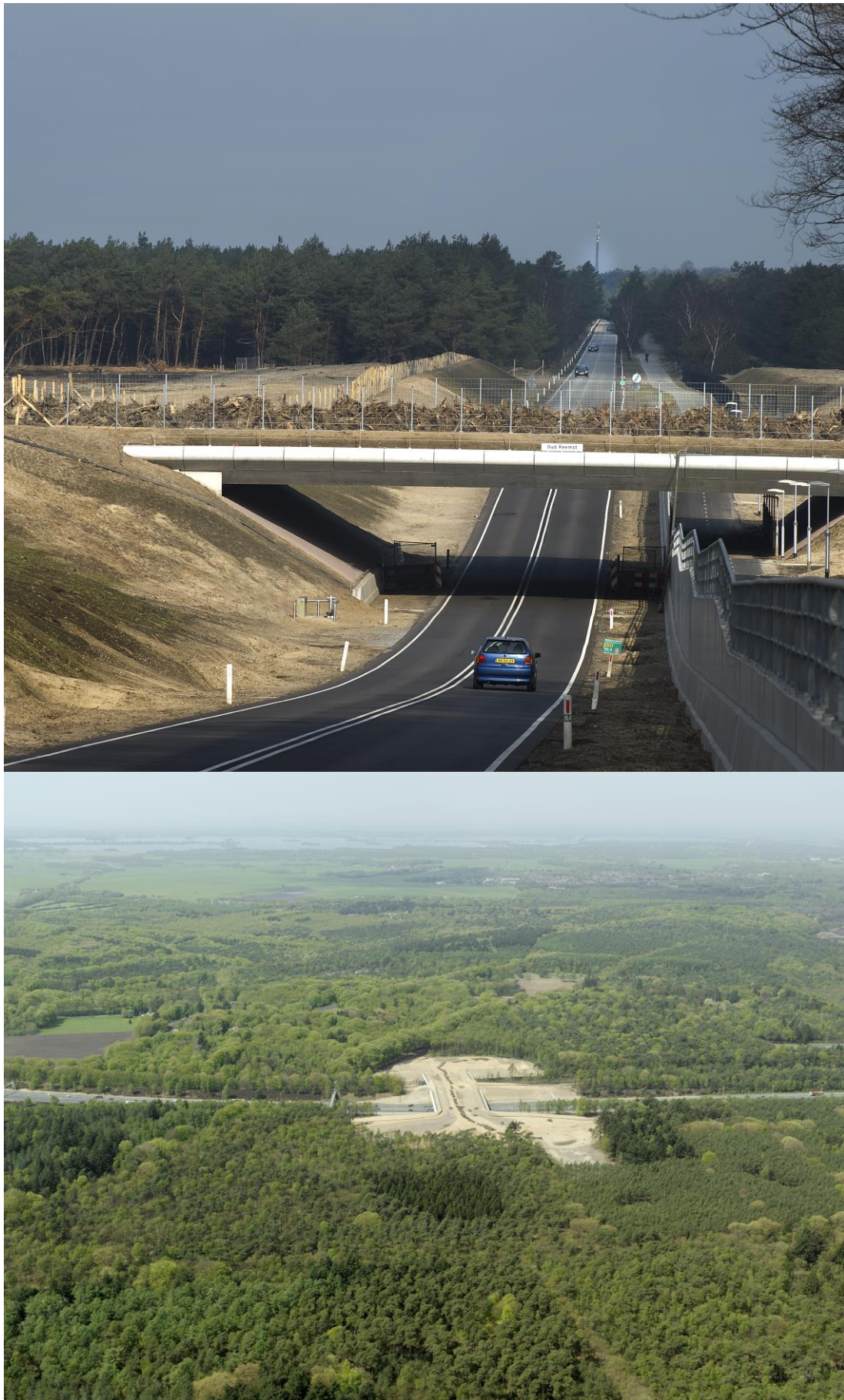
Boven: Ecoduct Oud Reemst; Onder: Luchtfoto ecoduct Zwaluwenberg, foto's door: H2Eco.
