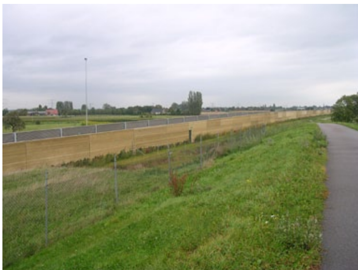
Figuur 1.2 Geluidschermen langs wegen en spoorwegen vormen echt ondoordringbare barrières. Dat geldt ook voor hekken die langs spoorwegen worden geplaatst om mensen van het spoor te houden.
