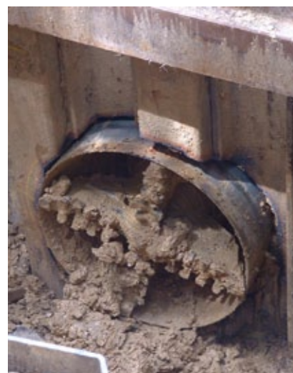
Figuur 4.12 Boorkop in ontvangstput van boormethode OFT (Open Front Techniek)
