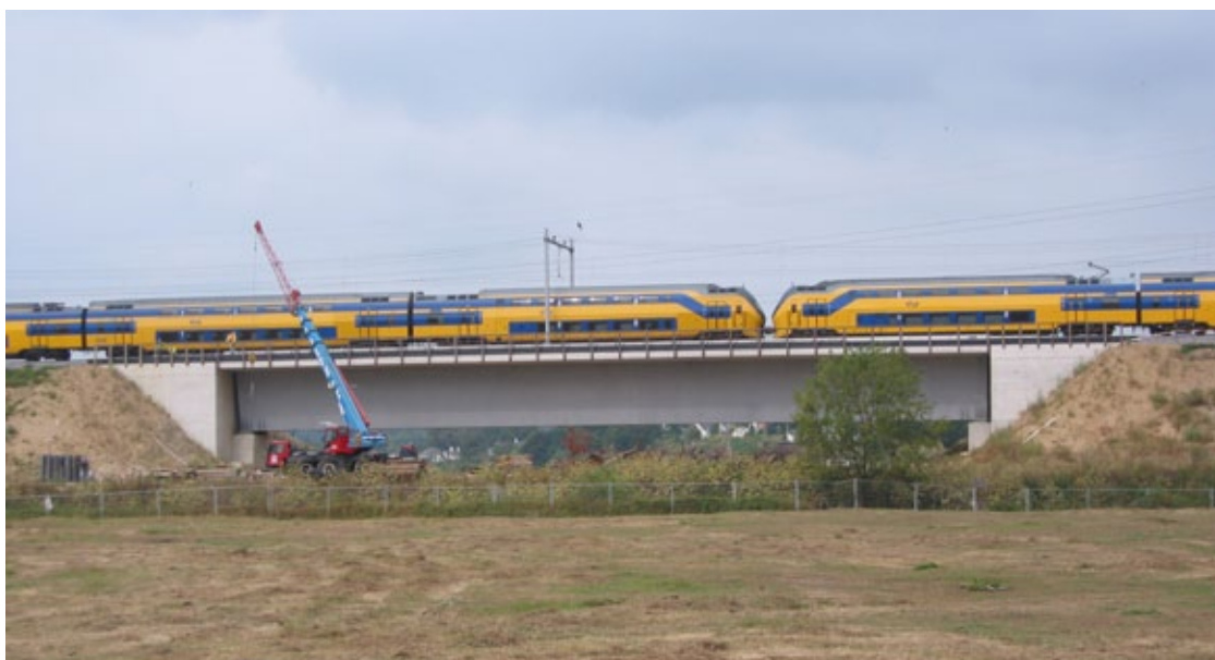
Figuur 3.6 De ecosysteembenadering vraagt om grootschalige oplossingen, zoals brede ecoducten of onderdoorgangen. Om de natuurlijke dynamiek van het rivierecosysteem langs de Rijn te behouden is in de Rosandepolder bij Oosterbeek een grote spoorbrug aangelegd (foto: Prorail).
