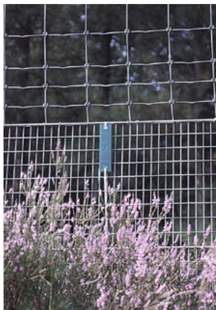
Figuur 5.2 Voor inspectie en onderhoud is het handig de plaats waar zich een faunapassage bevindt, te markeren. Bijvoorbeeld op het raster.
