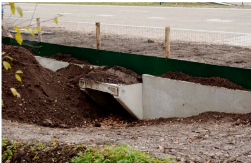
Figuur 4.14 Aanleg kleine faunatunnel (foto: Arfman).
