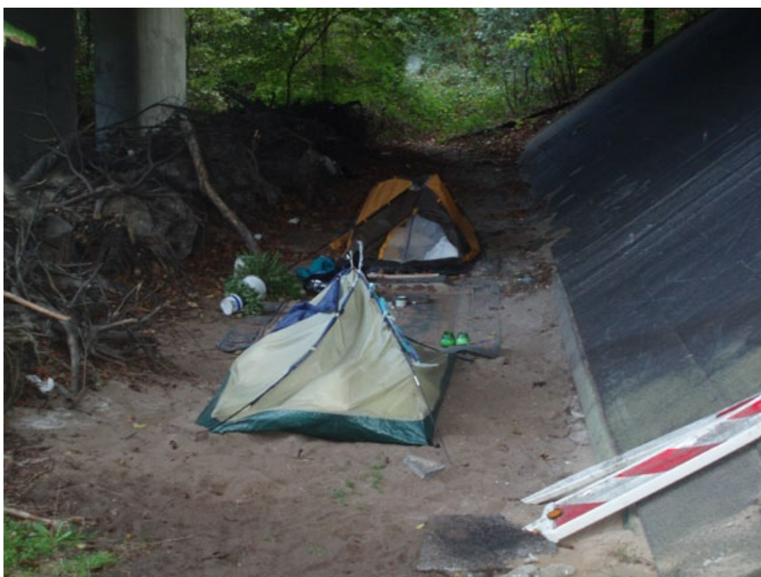
Figuur 5.5 Faunapassage niet gebruiken voor opslag materieel en slaapplek.
