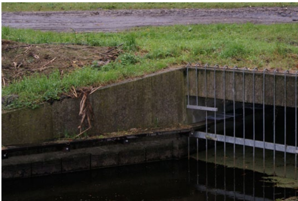
Figuur 8.110 Duiker met een loopplank en voorzien van spijlen, momenteel ongeschikt voor vleermuizen, maar indien aangepast (spijlen weg) een geschikte faunapassage voor met name watervleermuizen.
