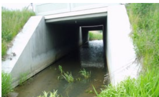
Figuur 8.40 De tunnel mag niet onder water staan.
