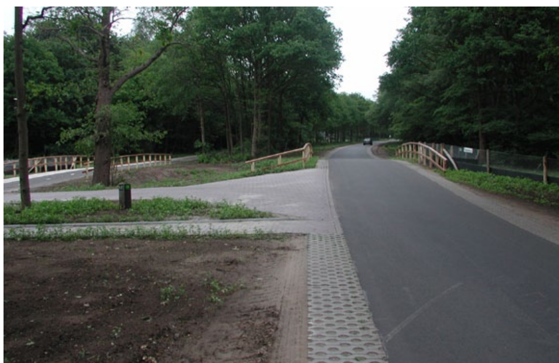
Fig. 8.153 en 8.154 Een voormalige rijksweg (80 km/u) is met een middengeleider en een verhoging ter hoogte van de beek tot een 60 km/u weg omgebouwd (foto's: Bert Stegehuis).
