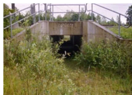
Figuur 8.66 Voorbeeld van ruim gedimensioneerde kleine faunatunnel (kleine tot middelgrote dieren).
