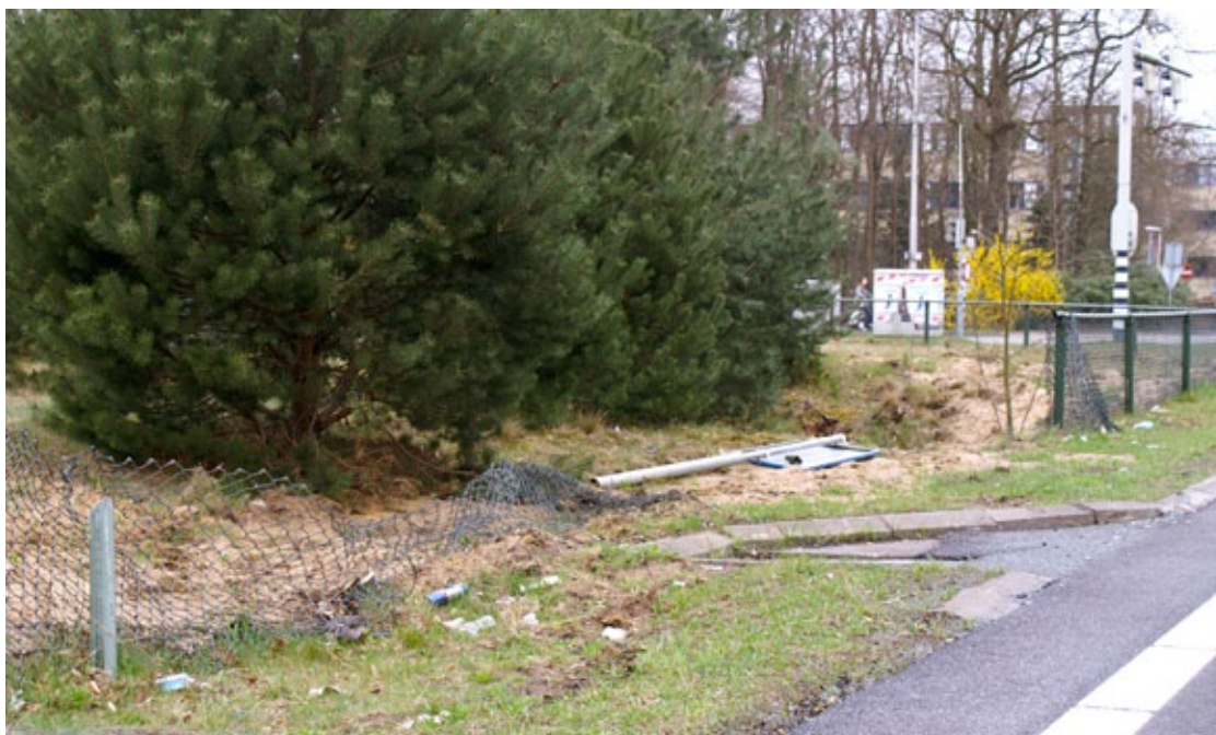
Fig. 8.143 Verwoest raster na een aanrijding.
