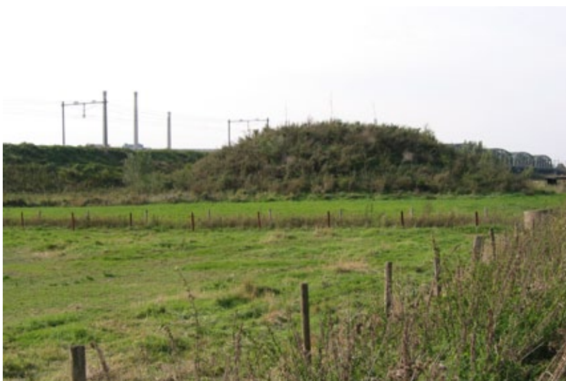
Fig. 8.169 en 8.170 Om te voorkomen dat dassen hun burcht in het talud van het spoor maken, is in de directe omgeving een terp aangelegd met een kunstburcht.
