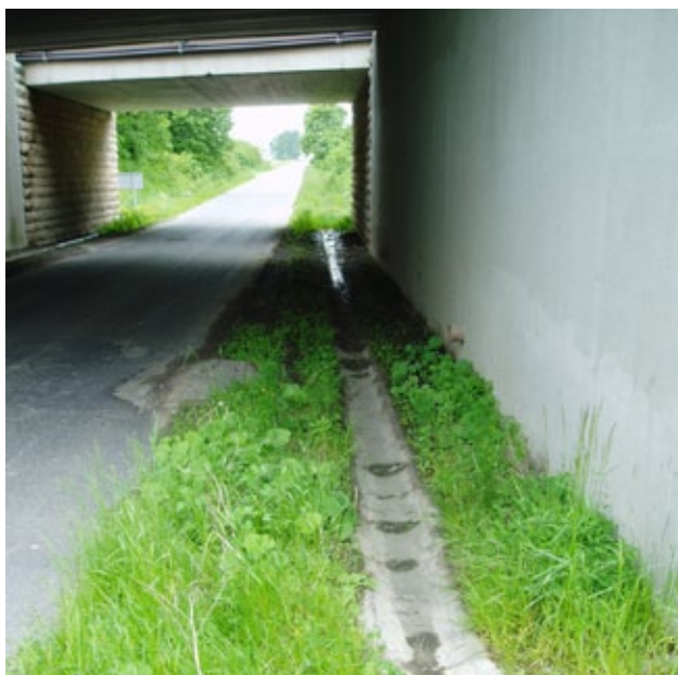
Figuur 8.97 Tunnel met onverharde strook.
