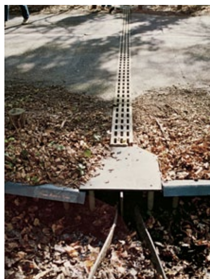
8.81 Voor amfibieën is extra geleiding naar de tunnelingang belangrijk (twee deels ingegraven kunststof platen).
