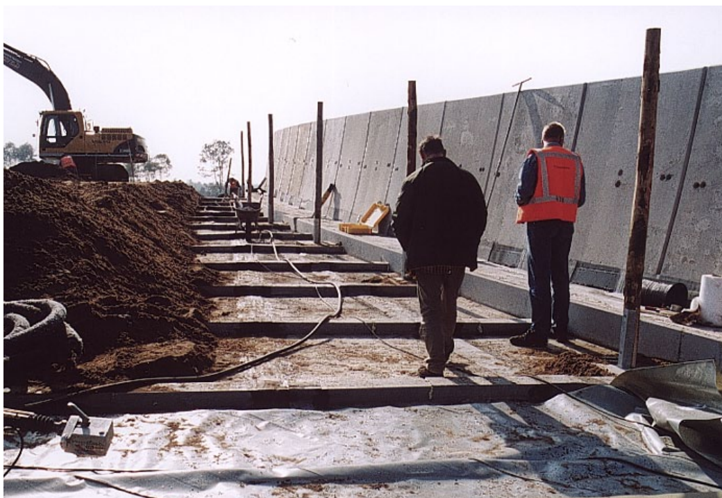
Figuur 8.24 Bovenop het ecoduct zijn betonbalkjes gelijmd om water vast te houden, zodat vocht langer beschikbaar blijft voor de begroeiing (De Borkeld, A1)
