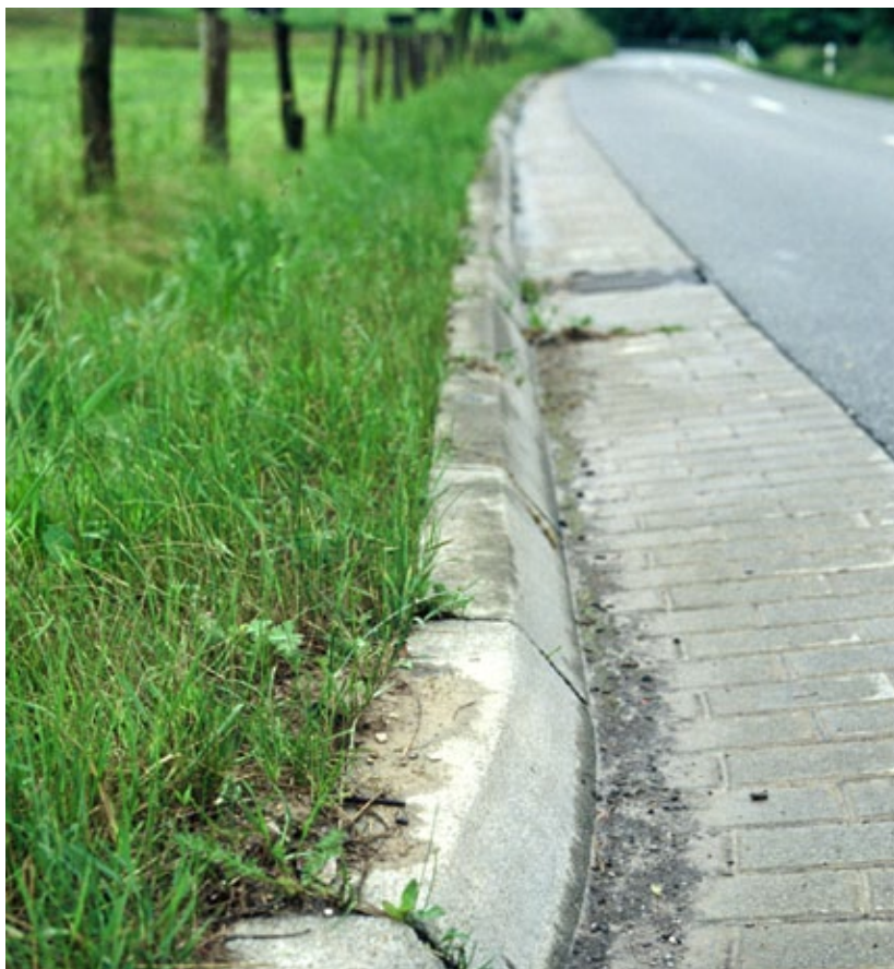
Fig. 10.167 Amfibievriendelijke trottoirband
