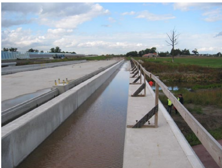
Figuur 8.96 Door de spoorbrug iets breder te maken, ontstaat ruimte voor een groenstrook voor fauna.
