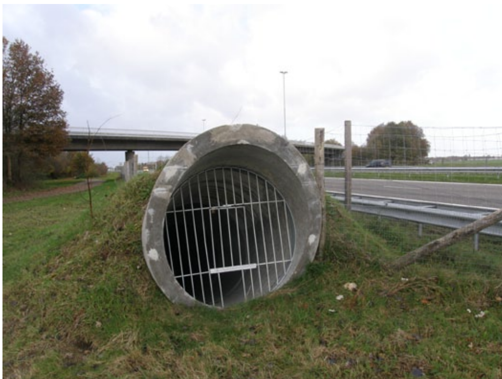
Figuur 8.75 Kindvriendelijke tunnel met rooster.
