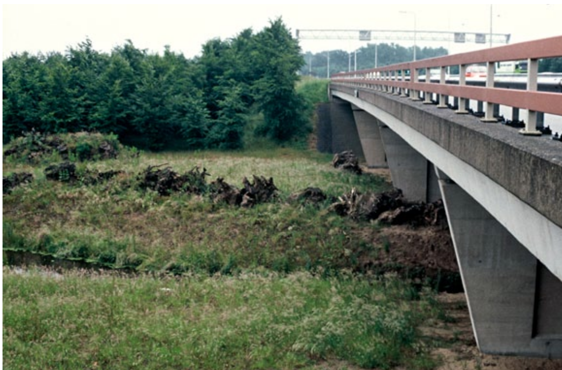
Figuur 8.32 Geleiding naar de onderdoorgang kan bijvoorbeeld met stobbenwallen en een watergang.
