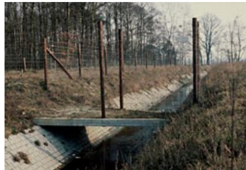
Figuur 8.164 Betonnen loopplank over sloot als aanvullende voorziening bij een dassentunnel.
