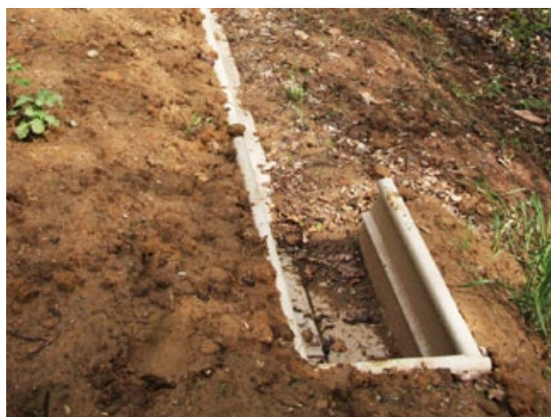
Fig 8-134 U-vormige constructie aan einde geleidewand (foto: Aco).
