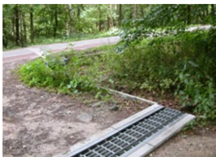
Figuur 8. 77 Amfibieënroostertunnel onder dwarsweg, waarbij de vegetatie, die nu als opstapje kan worden gebruikt, dient te worden verwijderd
