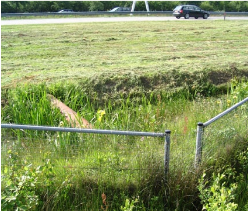
Figuur 8.124 Voorbeeld van een zeer lange faunabuis (ook gedeeltelijk over de sloot/greppel getrokken) die buiten het beheersgebied van RVS begint en eindigt: voordeel voor het maaibeheer in de berm, maar de grote lengte van de buis en de onbeikbaarheid van het bermhabitat zijn nadelen
