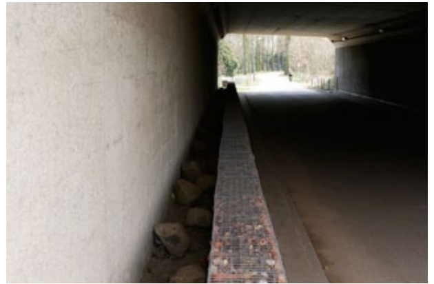
Fig. 8.120 Toepassing van niet brandbare dekkingvormers in randstedelijk gebied: schanskorven gevuld met kleine keien en een zandstrook voorzien van grotere keien.
