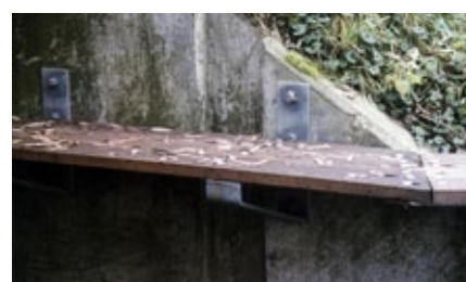
Figuur 8.108 Een degelijke bevestiging van de loopplank bevordert het duurzaam functioneren als faunapassage.
