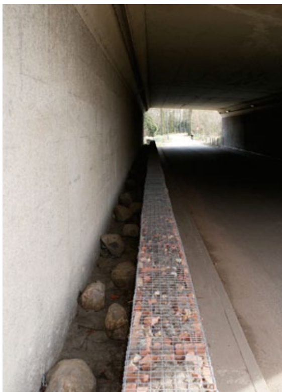
Figuur 8.101 Zelfs als in de tunnel weinig ruimte vrij is, kan hier een beschermde passagemogelijkheid voor kleine dieren worden aangelegd
