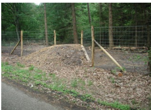
Figuur 8.139 Inspringvoorziening voor roodwild (Arfman)
