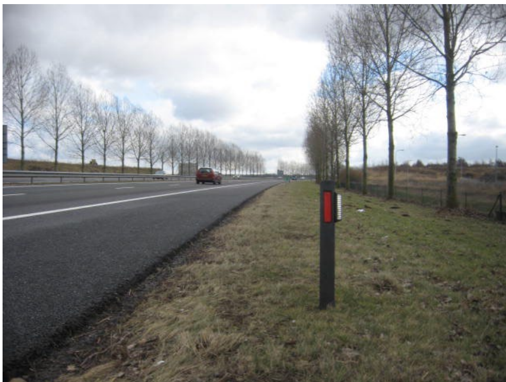
Figuur 8.147 en 8.148 Langs veel wegen zijn wildspiegels en wildreflectoren geplaatst om grotere zoogdieren met lichtflitsen van de weg te houden. Helaas schrikken de dieren nauwelijks van de lichtflitsen, waardoor dit middel weinig effectief is (Foto's: Dick Kuiper).
