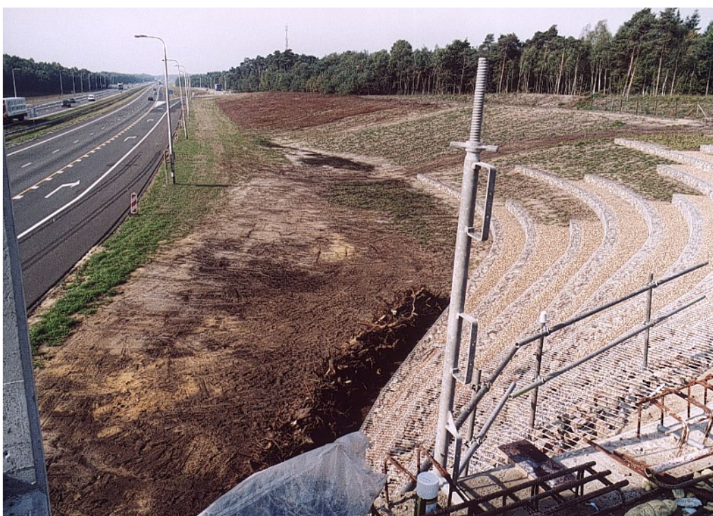
Figuur 8.25 Talud opgebouwd met schanskorven
