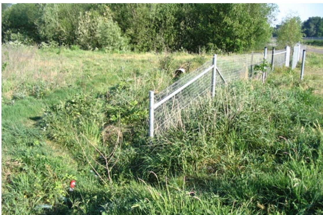
Fig. 8.142 Te kort raster, dassenwiel loopt er gewoon omheen.
