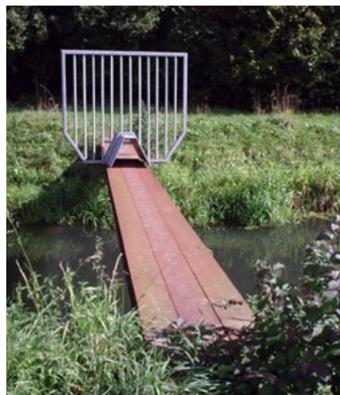
Figuur 8.163 Looproute voor kleinwild over sloot voorzien van hekwerk rooster om gebruik door mensen te voorkomen.
