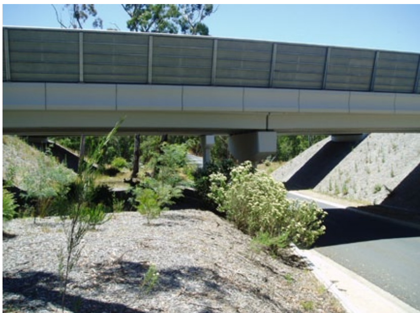
Figuur 8.100 Onderdoorgang in twee stappen (Australië).
