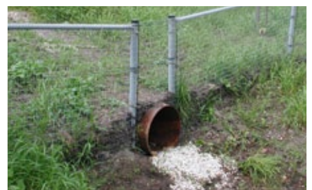
Figuur 8.74 Dassentunnel met goede aansluiting op raster.
