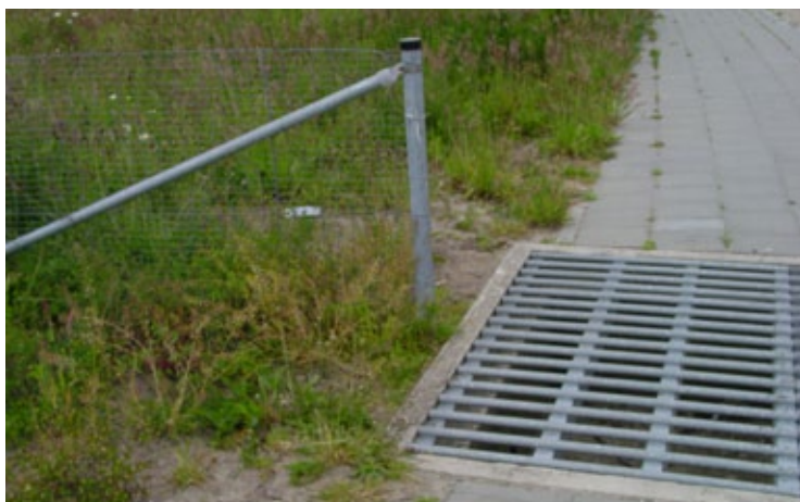
Fig 8.146 Raster sluit niet goed aan op wildrooster
