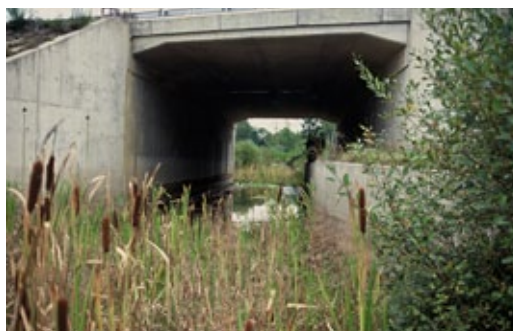
Figuur 8.46 Met een perronwand is een onverharde strook onder de brug gemaakt.
