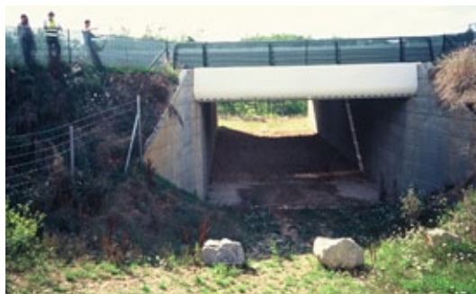
Figuur 8.42 Faunatunnel voor middelgrote dieren (ree), de grote stenen dienen om ongewenst medegebruik tegen te gaan.
