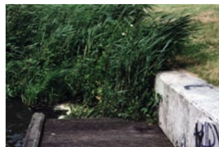
Figuur 8.107 Doordat deze kluunstrook niet aansluit op de oever, is hij ongeschikt als faunapassage. Tijdig overleg kan zorgen voor een gezamenlijke oplossing van verschillende problemen met weinig extra kosten.
