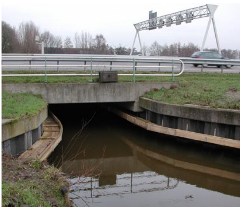
Figuur 8.106 Houten loopstroken met opstaande rand onder bestaande brug aangebracht, verbonden met de oevers .
