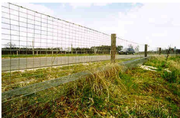
Fig 8-135 Kleinwild- en amfibieën timeraster; het fijnmazige raster wordt in verband met beschadiging bij onderhoud, het gemakkelijk inklimmen van dieren en de te grote maaswijdte voor jonge amfibieën bij voorkeur niet meer toegepast.
