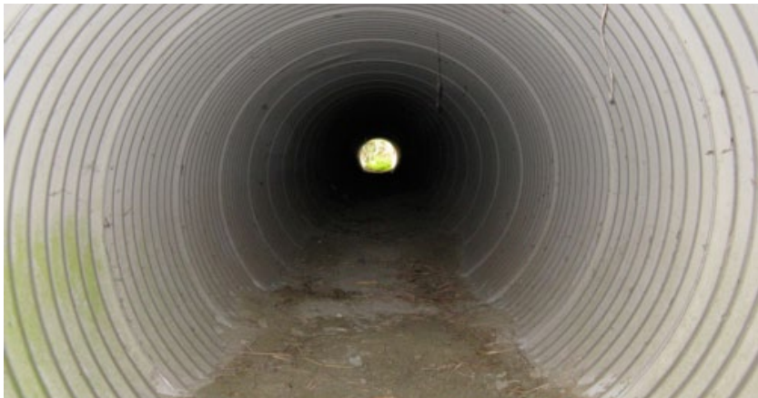
Figuur 8.68 Ronde faunapassage van gegolfde kunststof.
