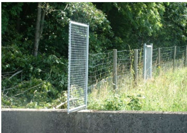
Figuur 8.130 Beëindiging raster op rand tunnelbak.
