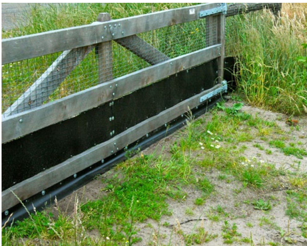
Fig. 8.137 Raster en werkpoort voorzien van dichte strook aan de onderzijde om amfibieën te keren.
