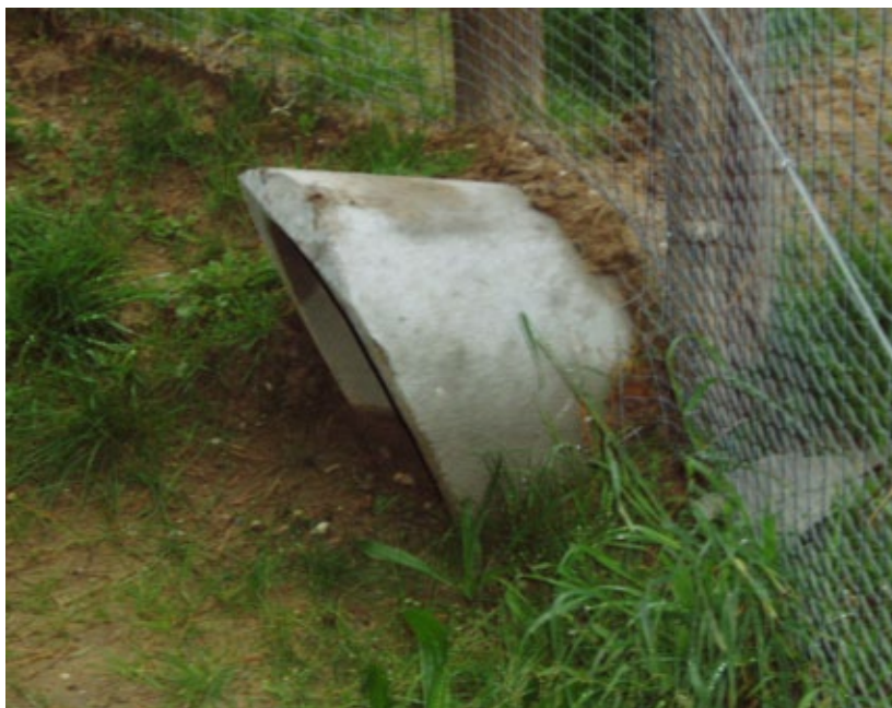
Figuur 8.72 Dassentunnel: door het schuine uiteinde zal het minder snel inregenen.
