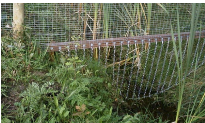
Figuur 8.122 Raster loopt door over sloot. De kettingen voorkomen passage langs de sloot, maar minder effectief dan het raster zelf. Indien de sloot droog staat, kan de kettingmat onder stroom worden gezet om de barrièrewerking te vergroten.
