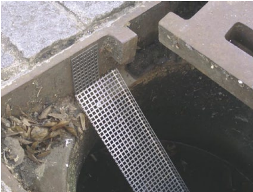
Fig 8.168 Metalen strip in straatkolk als uitklimvoorziening voor kleine dieren (paddentrapje) (foto: KARCH)
