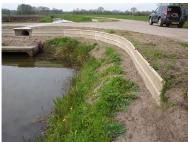
Fig 8-133 Amfibiegeleidewand (foto: Arfman).
