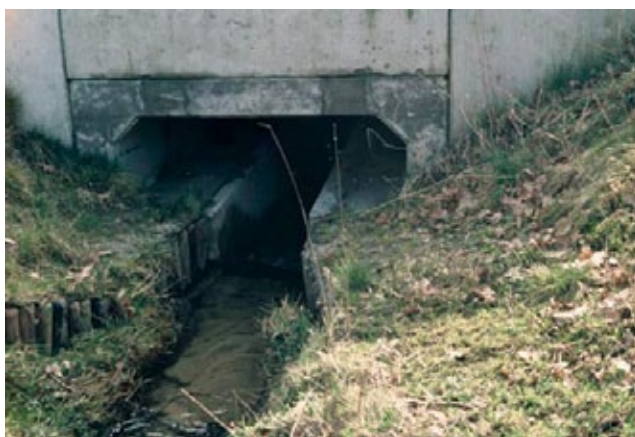
Figuur 8.56 Ecoduiker met aan beide zijden een loopstrook waarin grond is aangebracht.
