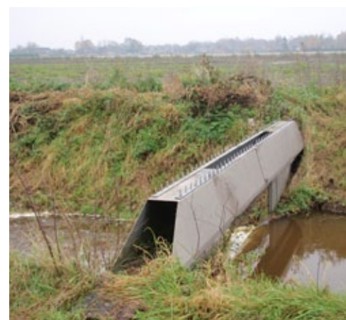
Figuur 8.165 Constructie om te voorkomen dat de loopplank door mensen wordt gebruikt.
