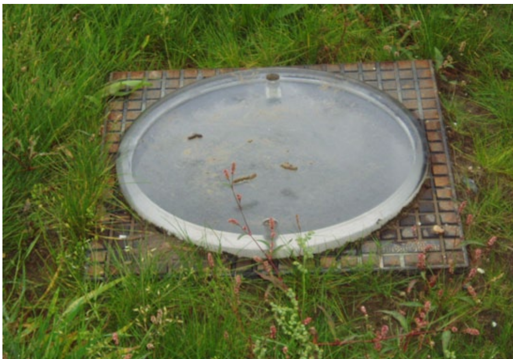
Fig. 8.159 Putdeksel van plexiglas; alleen zinvol indien jaarlijks schoongemaakt.
