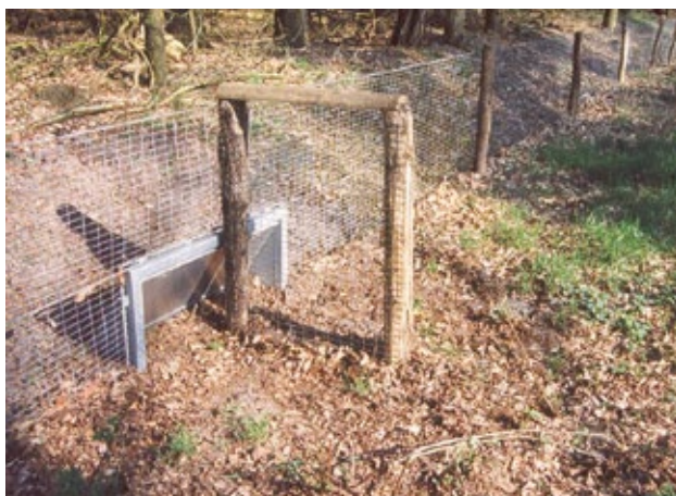
Figuur 8.138 Dassenpoort met dwangvleugel.
