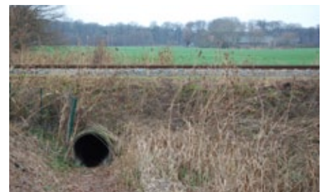
Figuur 8.73 Maar aan één kant van de tunnel een raster, waardoor dieren nog steeds het spoor over kunnen steken.
