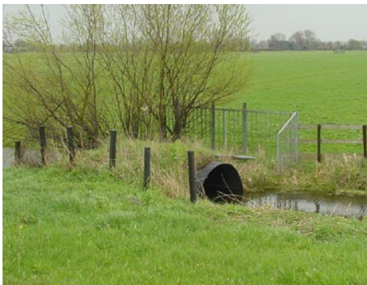
Figuur 8.161 Een dam met duiker in de sloot geeft een natuurlijker aansluiting dan een betonnen loopplank.
