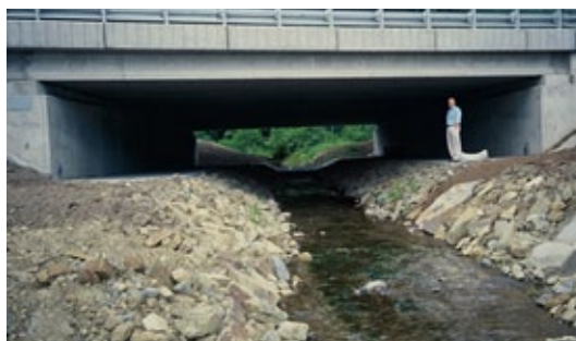
Figuur 8.41 Een waterloop door de tunnel zorgt voor extra geleiding en vergroot het aantal soorten dat de tunnel kan gebruiken.
