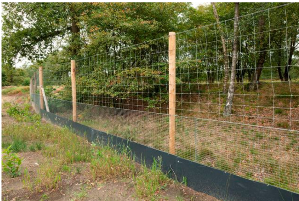
Fig 8.136 Amfibieënscherm en raster voor kleine respectievelijk grote dieren.
