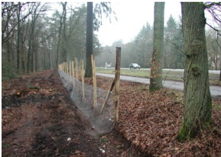
Figuur 8.128 Het raster moet worden ingegraven om gravende dieren tegen te houden (foto: Bert Stegehuis).
