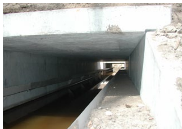
Figuur 8.57 Voorbeeld van een geïntegreerde betonnen looprichel met opstaande rand en gronddek.
