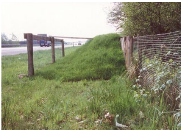
Figuur 8.140 Inspringvoorziening voor kleinwild (Arfman).
