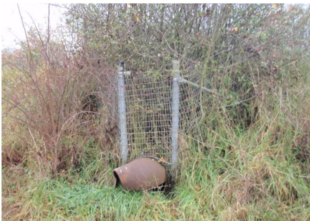
Figuur 8. 76 Door aanrijding ingeklapte buis.
