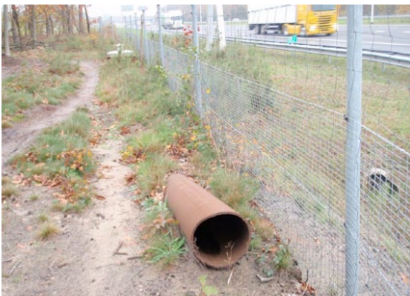
Fig. 8.125 Raster sluit niet goed aan op de buis, kleine dieren die strak het raster volgen, kunnen de buis hierdoor missen.
