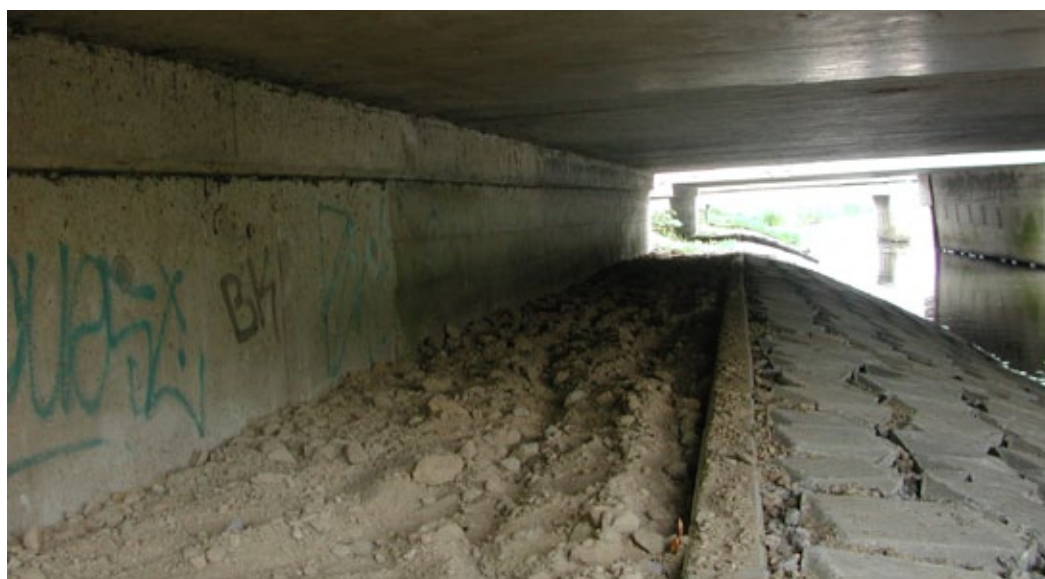
Figuur 8.47 Onverharde strook onder brug, talud met basaltblokken verstevigd.
