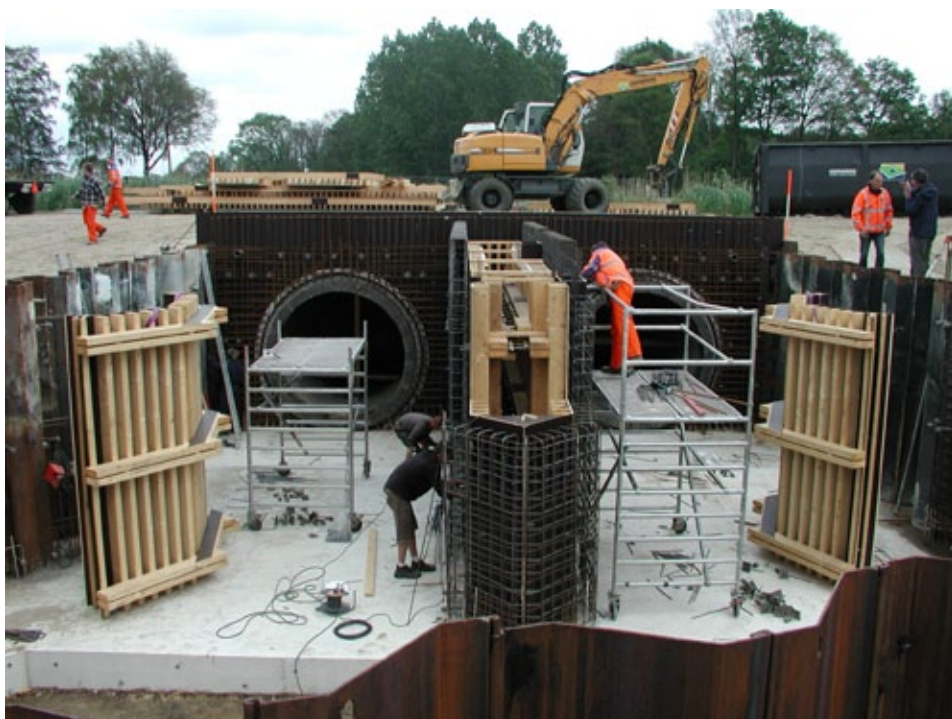
Figuur 8.117 Aanleg van twee sifons onder het Twentekanaal (foto: Bert Stegehuis).
