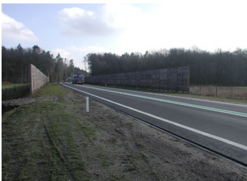
Figuur 8.90 en 8.91 Vanwege bladval en profielvrije ruimte (PVR) is het bij het spoor niet mogelijk om een echte hop-over te realiseren. Door de vegetatie zo dicht mogelijk naast het spoor te plaatsen, zal in ieder geval een deel van de fauna hoog over het spoor vliegen. Als extra voorziening kan een scherm worden geplaatst, zoals langs deze weg die een belangrijke trekroute van vleermuizen kruist (foto boven: ProRail, foto onder: Bert Stegehuis).
