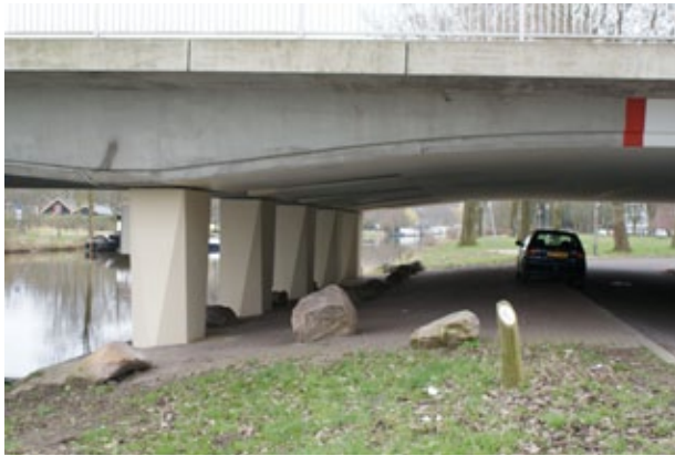
Fig. 8.119 Stenen stobben: brandpreventie en niet te verplaatsen door onverlaten.
