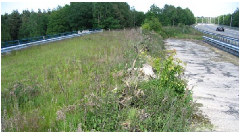
Figuur 8.92 Brede natuurlijk ingerichte strook op een viaduct over de A27 bij Hilversum: rechts van de stobbenwal is de strook verhard gelaten om het gebruik van de begroeide linkerzijde van de stobbenwal te stimuleren.
