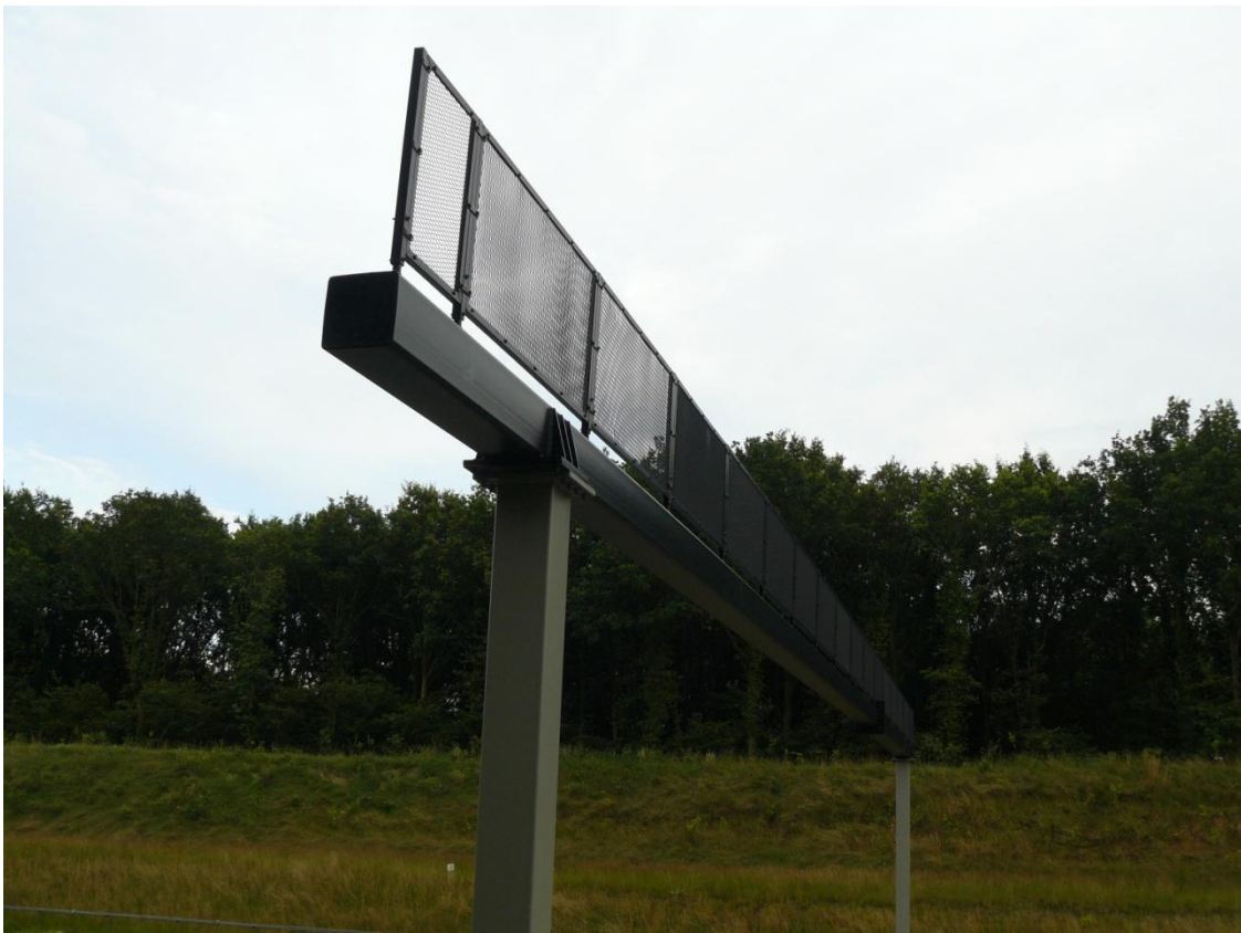
Voorbeeld van een kunstmatige hop-over (of bat gantry). In dit geval over de N 33 nabij Gieten (provincie Drenthe).
